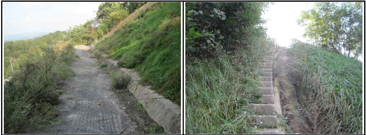
【그림 48.3.3】 배수시설 전경
